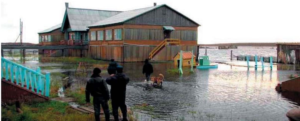
Рис. 2. Республика Саха (Якутия). Подтопление одноэтажных домов на сваях в результате таяния вечной мерзлоты
