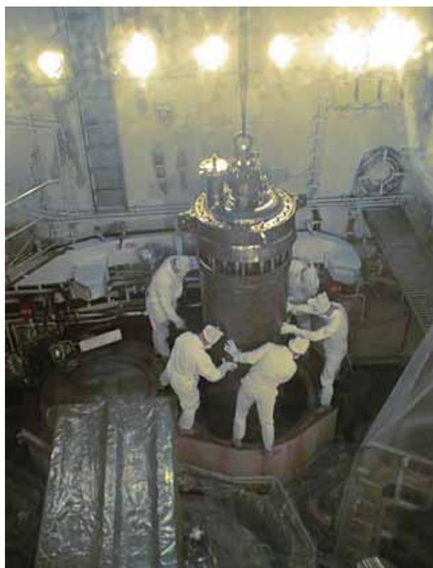
Замена внутреннего устройства парогенератора. Монтаж внутреннего устройства в корпус парогенератора бригадой специализированного участка предприятия и членами экипажа атомного ледокола
