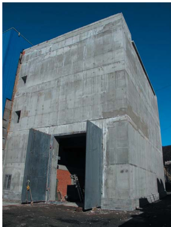
Рис. 4. Строительство берегового поста загрузки ОЯТ
