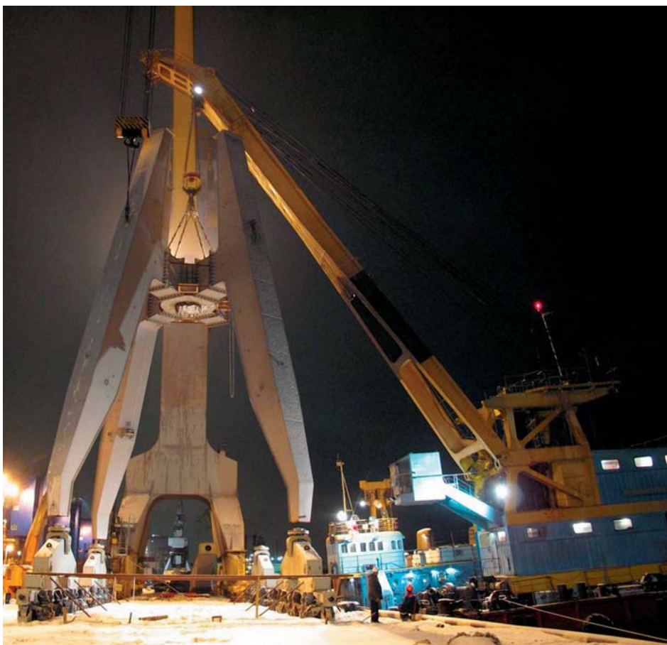
Рис. 9. Монтаж специального портального крана грузоподъемностью 100 т
