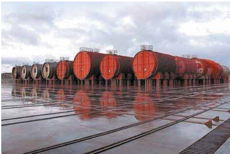
Рис. 4. Общий вид пункта долговременного хранения реакторных отсеков в губе Сайда Fig. 4. General view of the LSF RC (long-term storage facility for reactor compartments) in Sayda Bay
